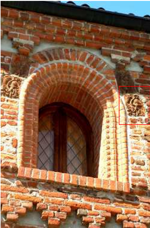
Fig. 8. Finestra della casa della Credenza sul lato nord con resti di decorazione in cotto
